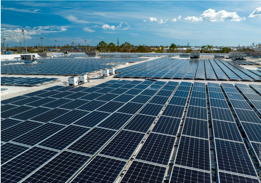
Photovoltaikanlagen decken den Energiebedarf eines Krankenhauses nur zu einem kleinen Teil. Ihr Wert liegt dennoch nicht allein im ökologischen Beitrag: Selbst erzeugte Energie verschafft ein gewisses Maß an Unabhängigkeit, das im Ernstfall den Unterschied machen kann.
